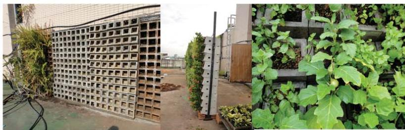
บล็อกผึ้งสำหรับปลูกต้นไม้แนวตั้ง มีลักษณะเป็นบล็อกค้อนกริดใช้รองแม่ห้องหรือรั้วที่มีช่องใส่เศษดินไม้ตัดอยู่ด้วย มีขนาด 15 x 15 x 25 ซม. รวมทั้งมีรูระบายน้ำหนักและล่างเพื่อให้น้ำไหลผ่านจากชั้นดินไปสู่รากของชั้นดินได้ดีที่สุด
